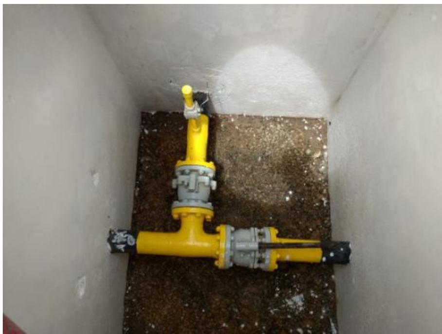
Figura 04 – Caixa de válvula típica
