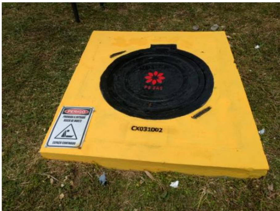
Figura 03 – Caixa de válvula típica
